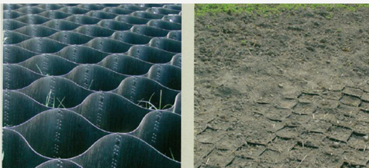
Material Geocell Dalam Keadaan Tergelar
